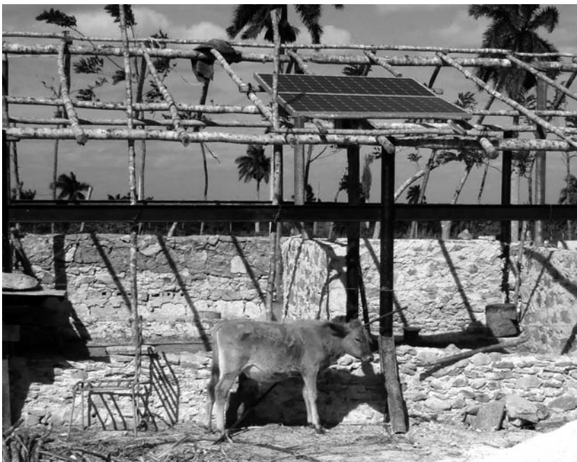
Construcción de una vacería en la Finca Marta, al oeste de La Habana
